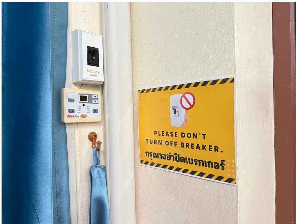
ป้ายการใช้งานเครื่องปรับอากาศในห้องปฏิบัติการคอมพิวเตอร์
